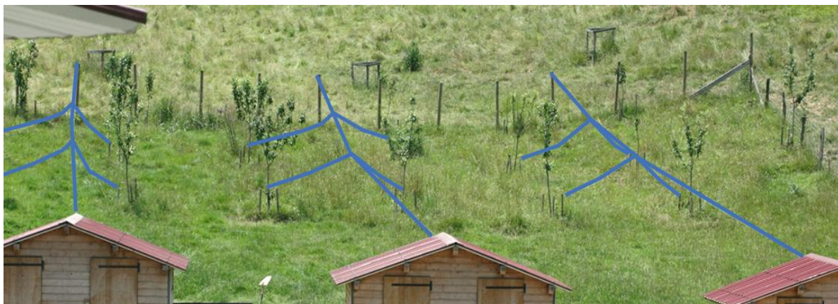
Photo 23. Protection électrique aérienne, raccordée au réseau d'une maternité. Installation en épi.
