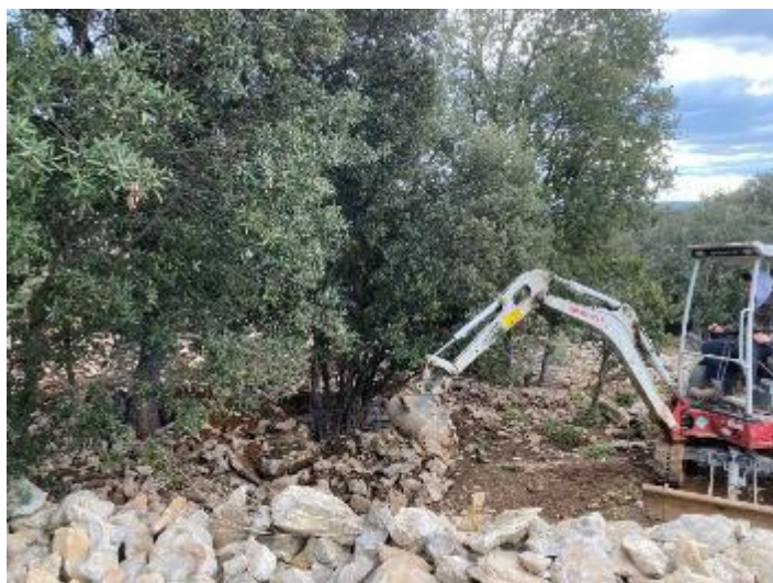
Photo 53. Installation d'un cordon de pierre autour de cépées à protéger.
