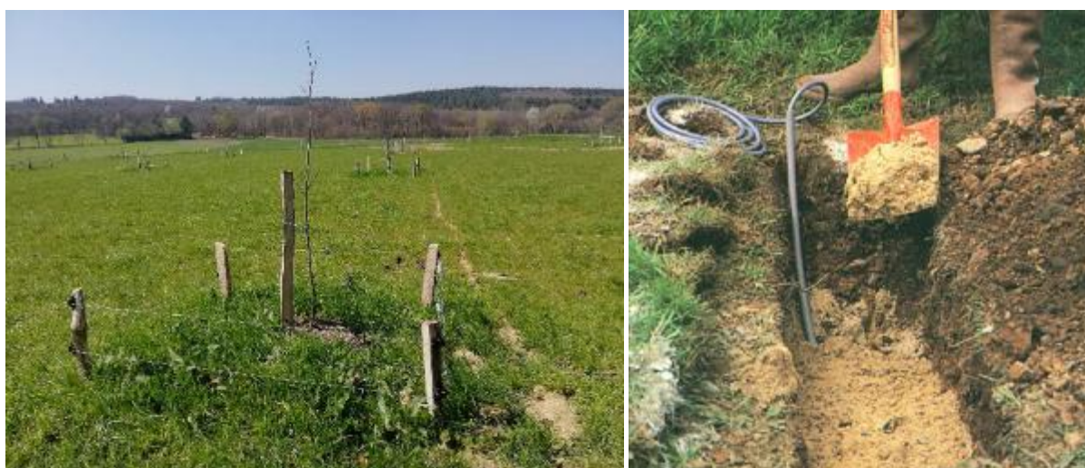
Photo 20. Protection d'arbres isolés par fil électrique enterré.
