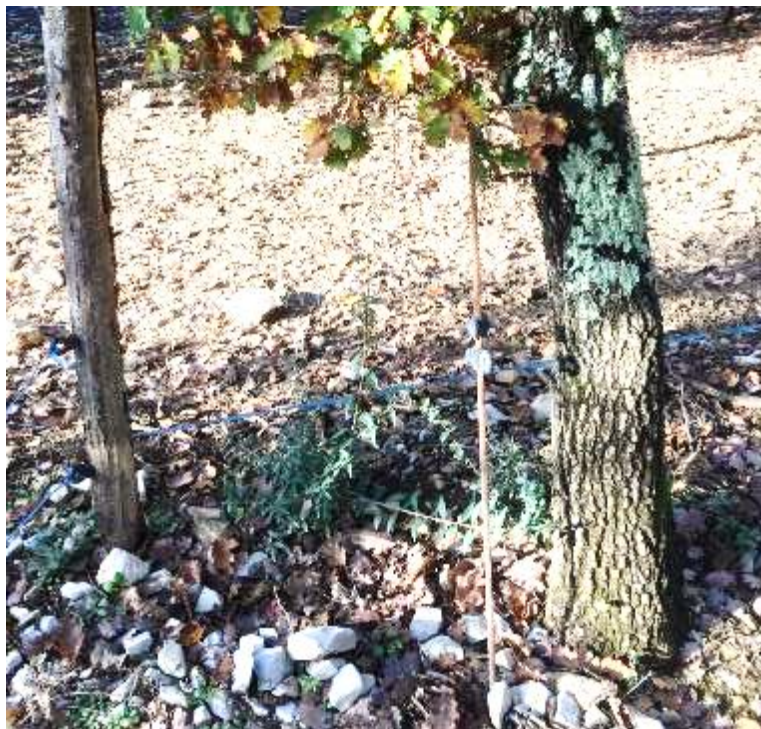
Photo 31. Arbre de bordure protégé à l'extérieur du fil, avec isolateurs sur poteau ou piquet.
