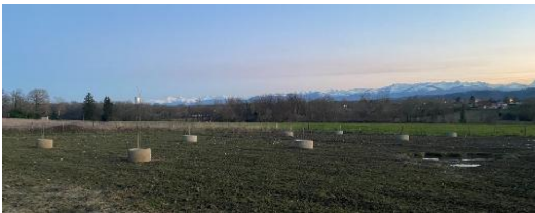
Photo 50. Vue d'ensemble d'une parcelle plantée avec buses béton en protection.
