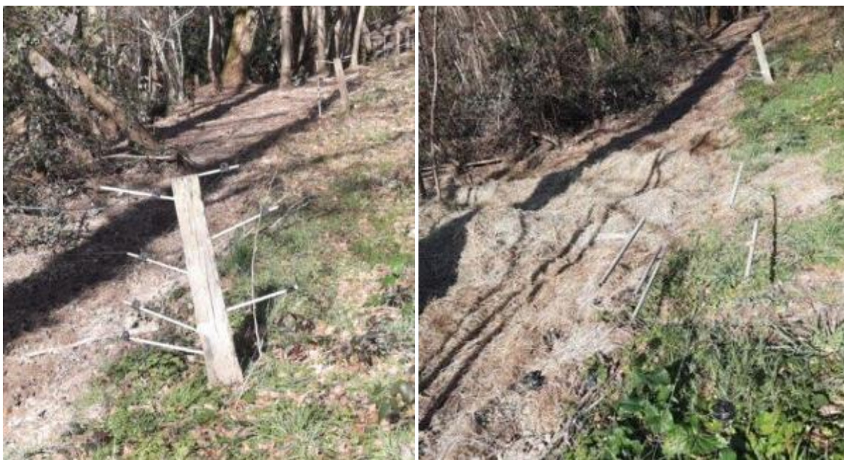
Photo 27. Installation de clôture électrique à 5 fils (3 à l'extérieur et 2 à l'intérieur du paddock). Les poteaux possèdent plusieurs supports pour passer un fil bas sur un support haut libre pour favoriser le débroussaillage au sol. Les fils sont tendus avec tenseurs (à droite), ce qui permet d'avoir de grandes longueurs de fils et moins de manipulations.
